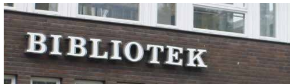
Bilden visar enkelsidig fasadskylt i form av lösa bokstäver, Åmål. Foto: SBK Värmland AB.
