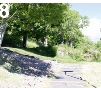
8 Asfalterad trappgång från Strandgatan till huvudstråket på Kungsberget.
