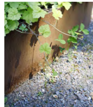
CORTENSTÅL Plantering i Plantaget, Åmål där kommunen använt sig av materialet cortenstål. Materialet är ett rosttrögt stål som efter en tids exponering får ett skyddande och estetiskt tilltalande rostskikt.
