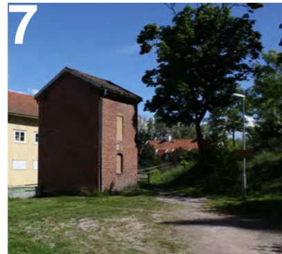
7 Plats med transformatorstation.
