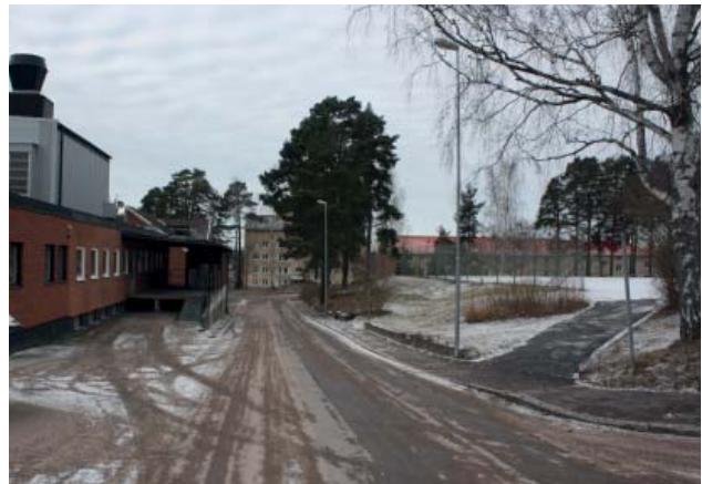
Bilden ovan visar den västra delen av Per Anderssons gata som föreslås övergå i kvartersmark för skola, vy västerut.
