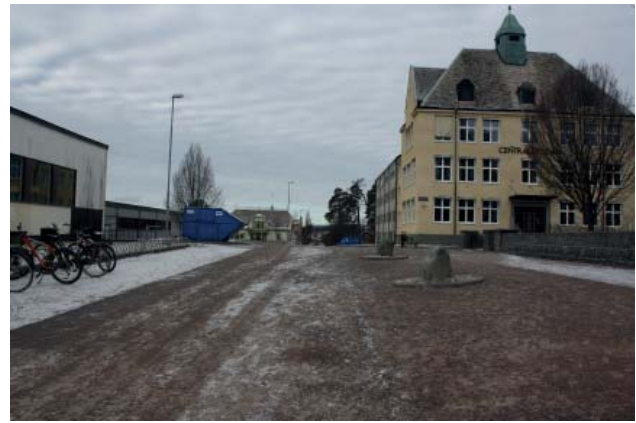
Ovan: Centralskolan till höger i bild, sett från öster.
