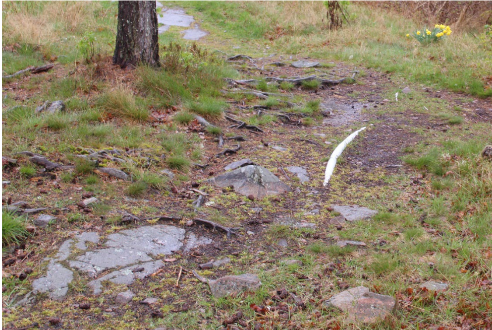
Ovan syns rör med nedgrävd elledning till befintlig bebyggelse i området.
