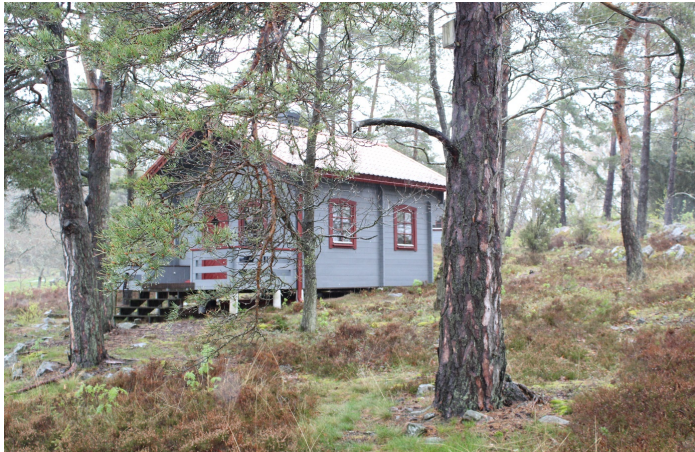
En av de befintliga uthyrningsstugorna av fabrikatet Arbråstugan, med grundläggning som anpassats till topografin i området, vy mot nordost.
